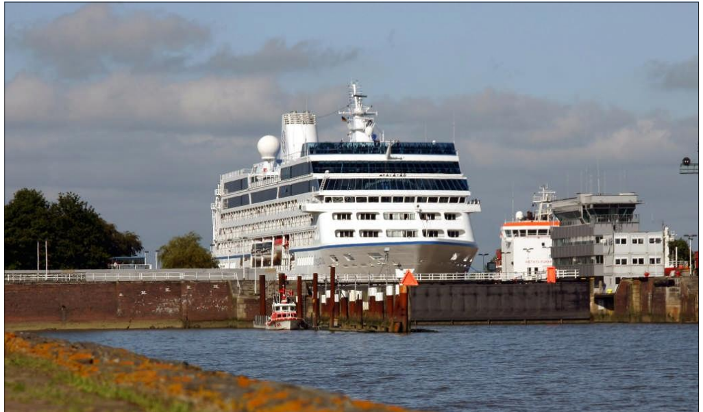
Der Nord-Ostsee-Kanal ist sanierungsbedürftig. Allein die 100 Jahre alten Schleusentore in Brunsbüttel fielen im Jahr 2010 umgerechnet insgesamt 113 Tage aus. Foto: Sievers/Stadt Brunsbüttel
